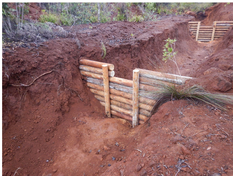
Photo 4 - Exemple de de dispositifs de gestion des sédiments sur mines (Source : Géoimpact)
