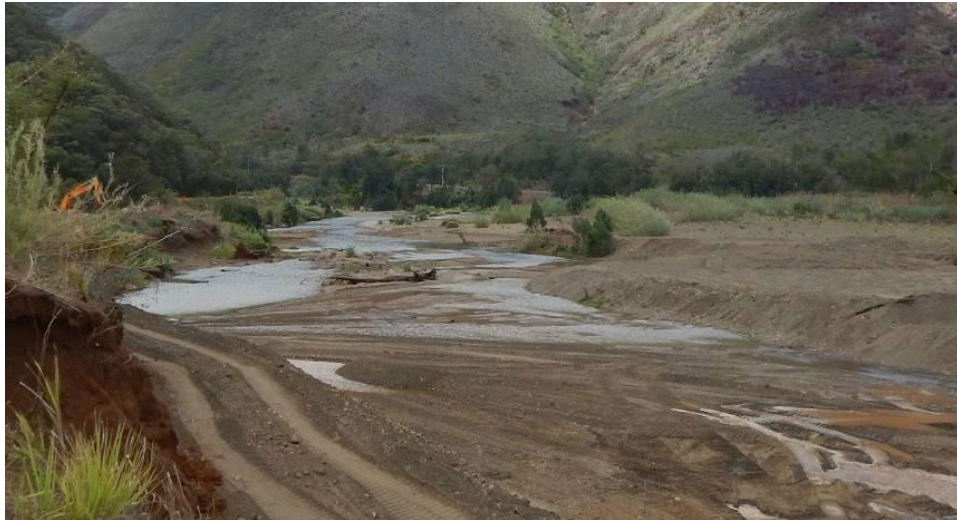
Photo 3 prise sur la Nakalé à Thio (Source DAVAR), illustrant un curage du cours d'eau
